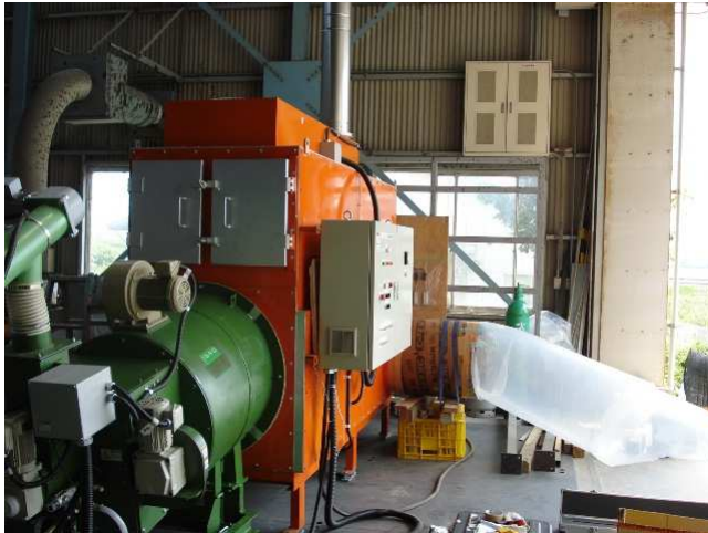
写真1 ハウス用加温機の外観
